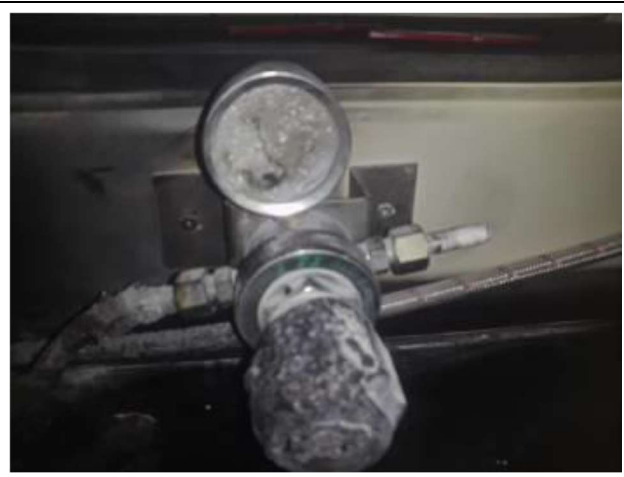
圖 2. 瓦斯管路接頭纏有止水帶，更易鬆脫
